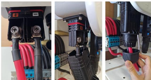
Conecte el terminal positivo y negativo en los bornes del inversor.
